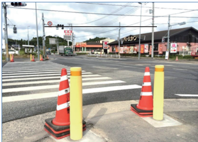
8/ 末に新設された鉄製ポール（酒々井バーミヤン前）
