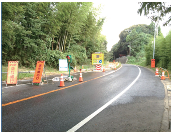
片側通行が続く県道宗吾酒々井線 下岩橋付近
