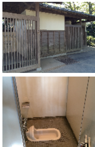
老朽化が進む房総のむらのトイレ
