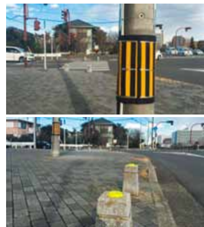
安全対策が講じられた県道交差点
