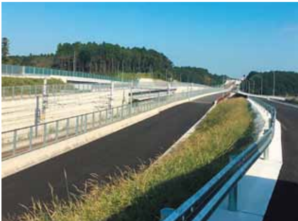
北千葉道路工事区間 (H28.10 印西市若萩)
