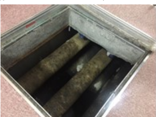
廊下下に埋められた配管
