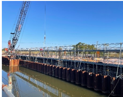
旧長門川橋 工事現場
