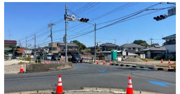
交差点内のコンクリートブロック(写真左側)
