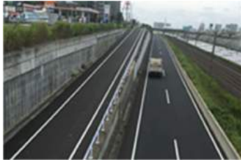
北千葉道路 草深オフランプ
