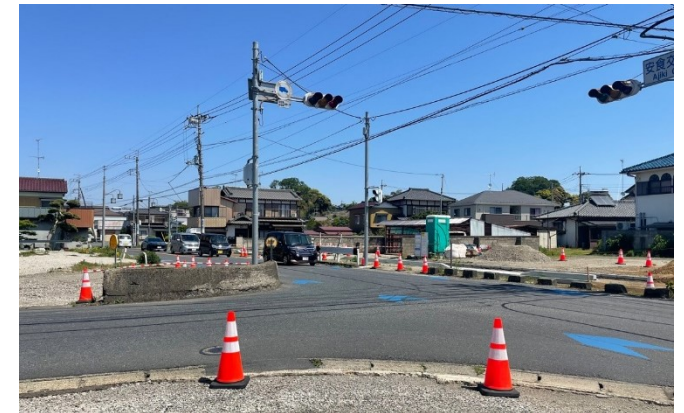
交差点内のコンクリートブロック(写真左)
